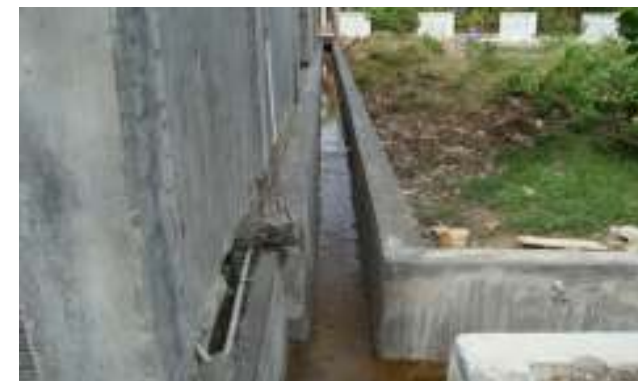
Gambar 23. Pembangunan Dainase Kec. BandaRaya
