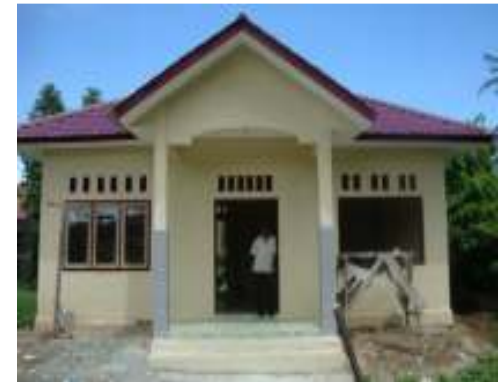
Gambar 47. Pembangunan Kantor Geuchik Lamseupung
