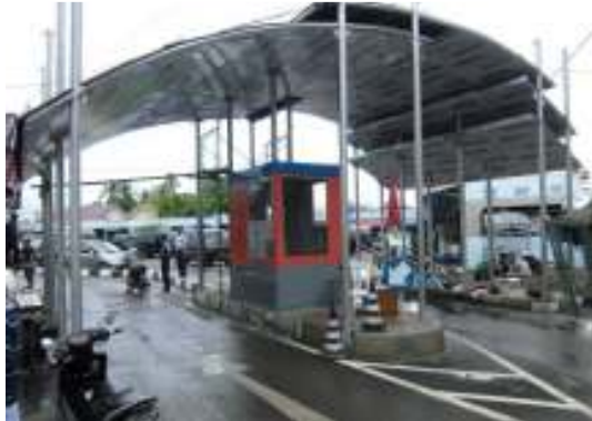
Gambar 26. Pengaspalan dan Pembangunan Pintu Gebang Teminal L300
