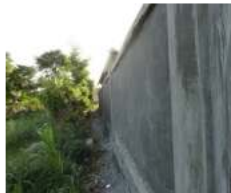
Gambar 2. Pembangunan Pagar SDN 53
