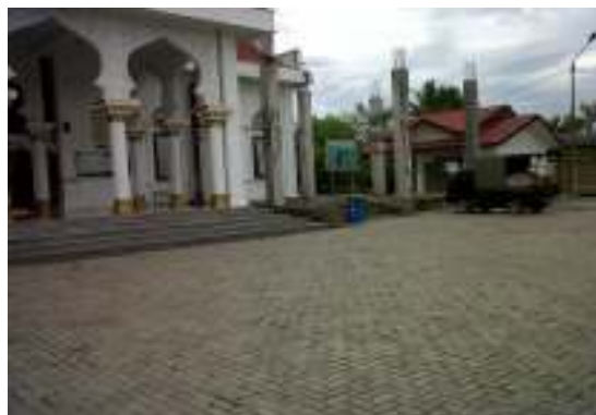
Gambar 22. Pembangunan Mesjid Syuhada Gp.Lamgugop
