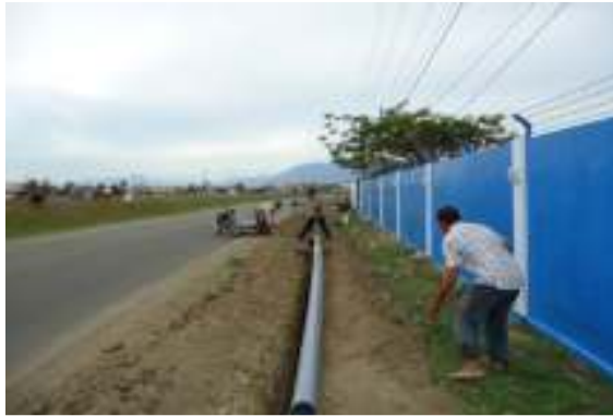
Gambar 15. Pemasangan Pipa Tersier Wil.Tengku Dianjong (Otsus)
