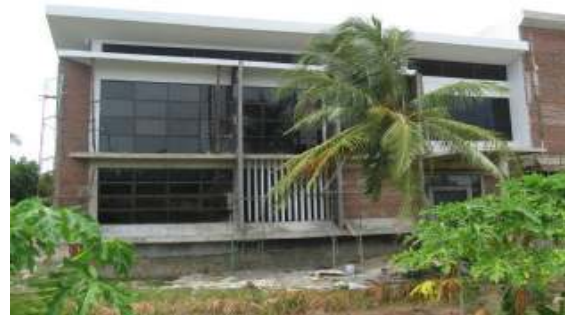
Gambar 19. Lanjutan Pembangunan Gedung Kantor Camat Ulee Kareng
