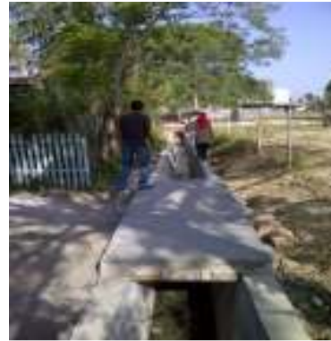
Gambar 16. Pembangunan Parit Asrama Gabungan Geuceu Meunara CS
