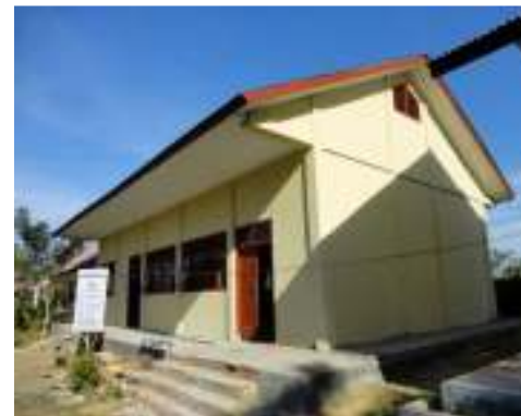
Gambar 8. Rehab Bangunan Laboratorium SMAN 9
