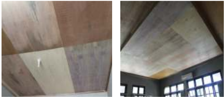
Gambar 41. Rehabilitasi Kantor Camat Baiturrahman Kota Banda Aceh
