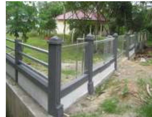
Gambar 55. Pembangunan Pagar Pasar Hewan
