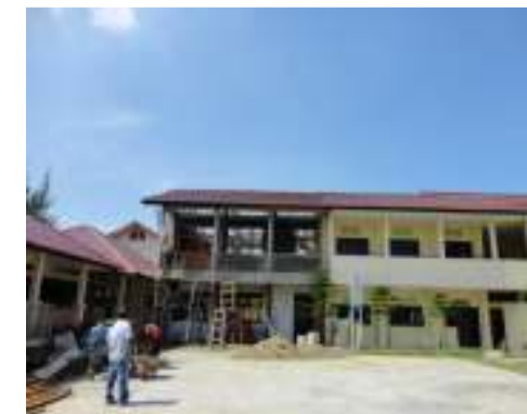
Gambar 3. Pembangunan RKB SMAN 13 Banda Aceh
