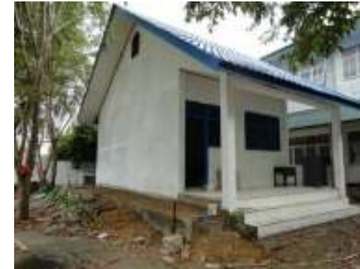
Gambar 6. Penyelesaian Pembangunan Ruang OSIS SMAN 6
