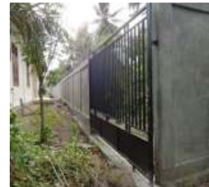
Gambar 9. Pembangunan Pagar SMAN 12 Banda Aceh
