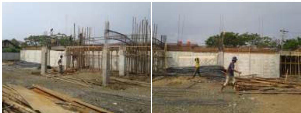
Gambar 14. Pembangunan Gedung IGD
