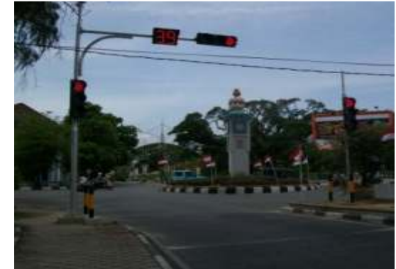
Gambar 27. Pembangunan Traffic Light Sp. Jam (Otsus)
