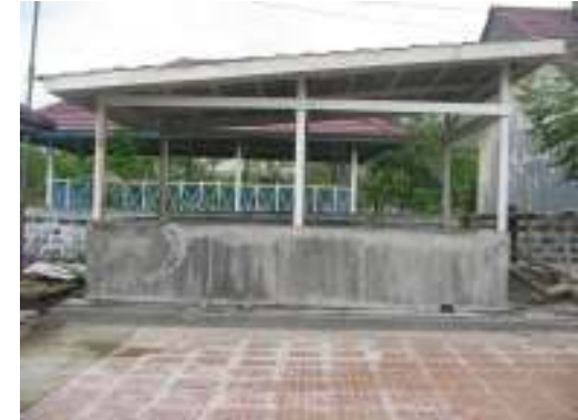
Gambar 52. Pembangunan Bak Limbah dan Akses Jalan Masuknya
