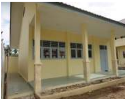
Gambar 1. Pembangunan Laboratorium Komputer SMPN 13 Banda Aceh
