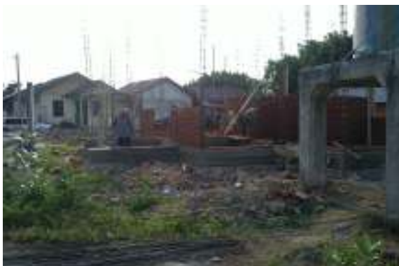
Gambar 21. Pembangunan MCK Plus Alue Deah Teungoh
