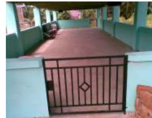
Gambar 20. Pembangunan Balai Pengajian Gp. Lamdom
