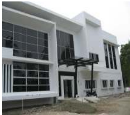
Gambar 18. Lanjutan Pembangunan Gedung Kantor Camat Lueng Bata
