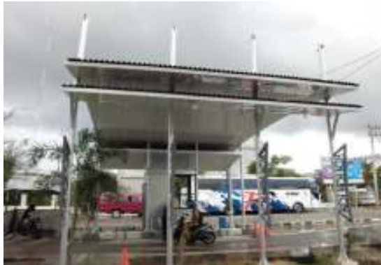
Gambar 25. Pembangunan Pintu Gerbang Terminal Type A (Otsus)
