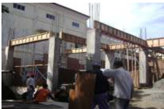
Gambar 13. Pembangunan Revitalisasi Puskesmas Kuta Alam
