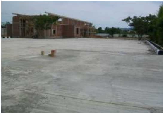
Gambar 28. Pembangunan Area Parkir Ged.Pengujian Kendaraan Bermotor (Otsus)
