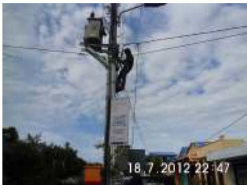
Gambar 30. Pembuatan Jaringan Instalasi dan KWH
