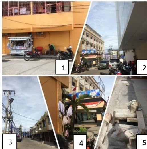
Gambar 4.23 Kondisi eksisting jalur pejalan kaki pada koridor IV Keterangan : 1. Kondisi pedestrian bagian gunung salju 2. Kondisi pedestrian bagian natasha 3. Kondisi pedestrian bagian depan Sulten Hotel
