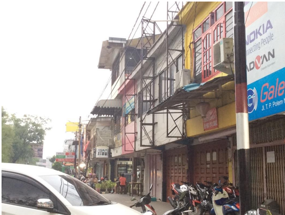
Gambar 2.2 Permukiman Jenis Rumah Toko (RUKO)
