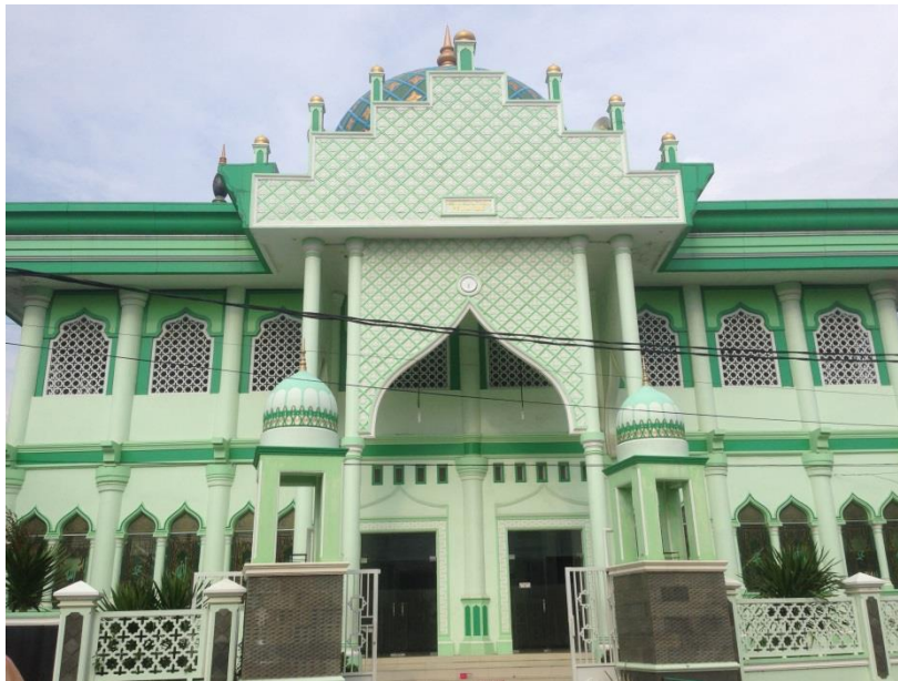
Gambar 3.80 Prinsip green building belum diterapkan di Peunayong
