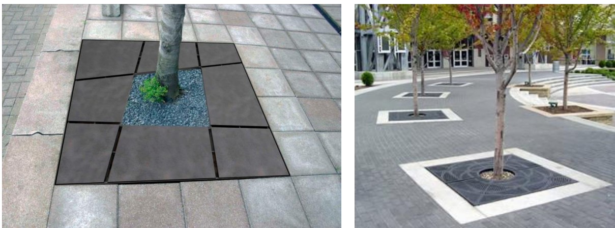
Gambar 3.26 Pemasangan Tree Crates agar pohon tidak merusak jalur pedestrian
