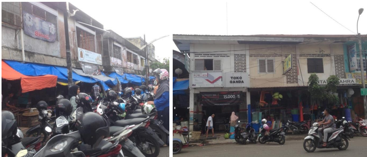
Gambar 3.79 Bangunan-bangunan di Peunayong tidak dirawat dengan baik
