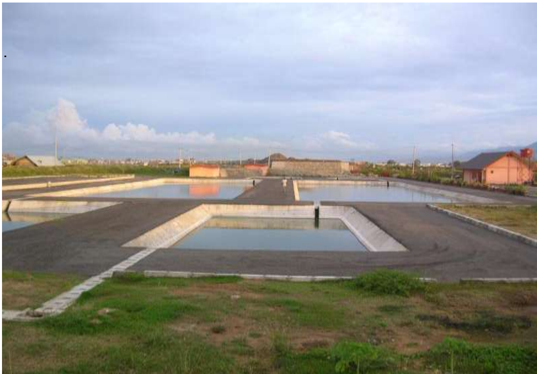
Gambar. 3.8. IPLT DI GAMPONG JAWA YANG DIREHABILITASI PADA DESEMBER 2005
