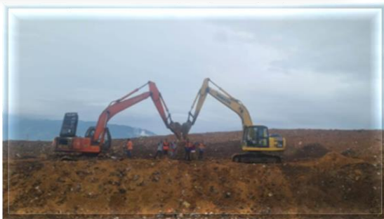
Foto 5 : Excavator Jumlah 5 unit Kondisi : 3 RB, 2 RR (Befungsi) Foto diambil : 15/2/2024
