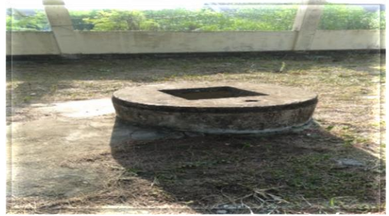
Foto 4 : Sumur Pantau TPA Gampong Jawa Foto diambil : 15/2/2024
